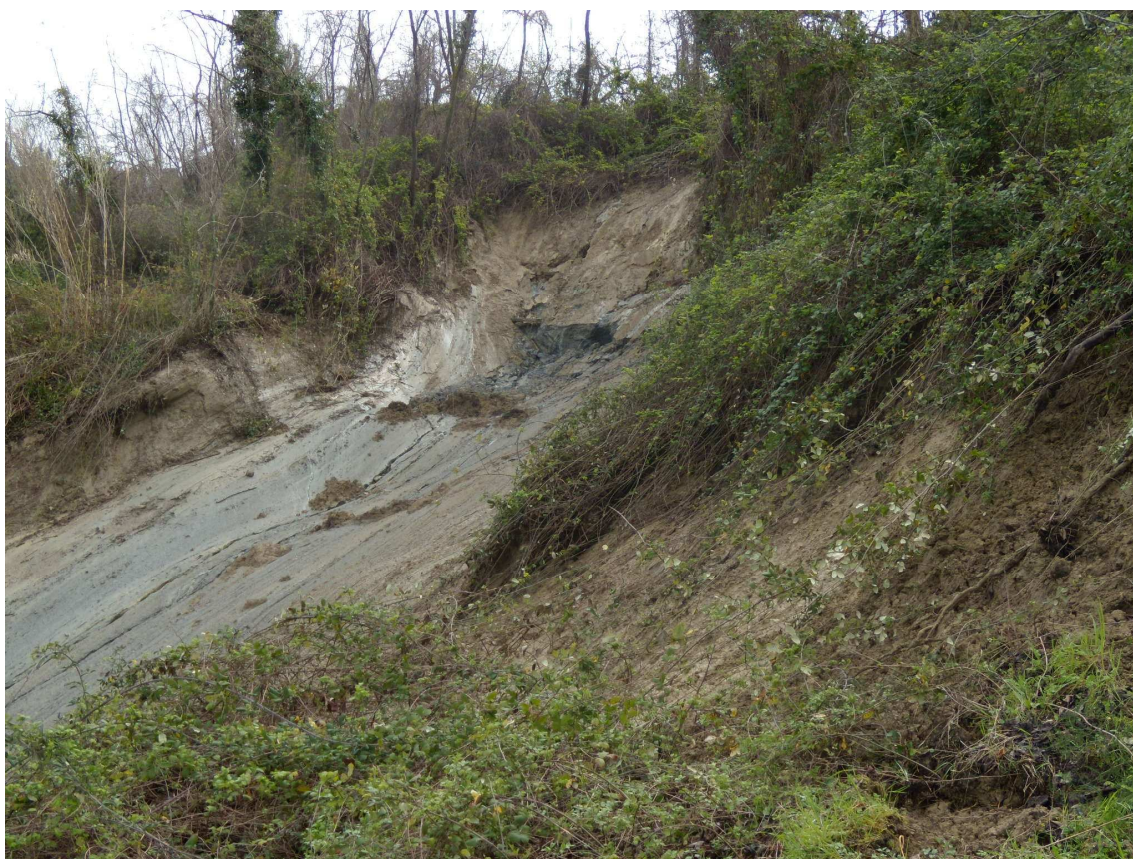
Frana di scivolamento
