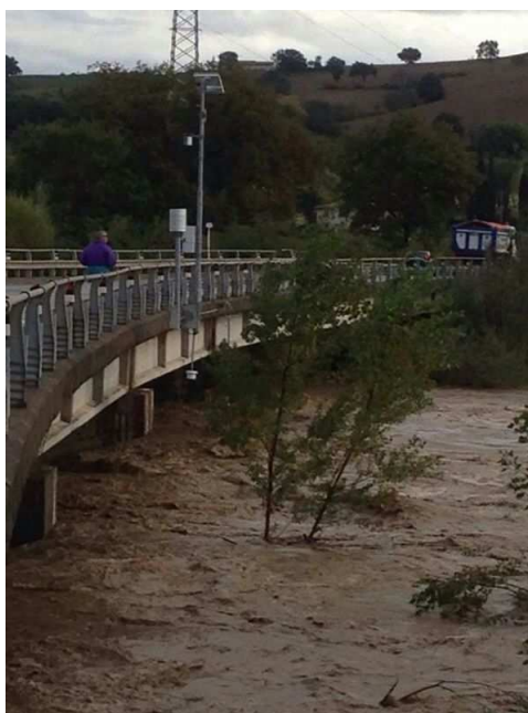
Stazione idropluviometrica Fiume Cecina Ponte SR 439 (21/10/2013)
