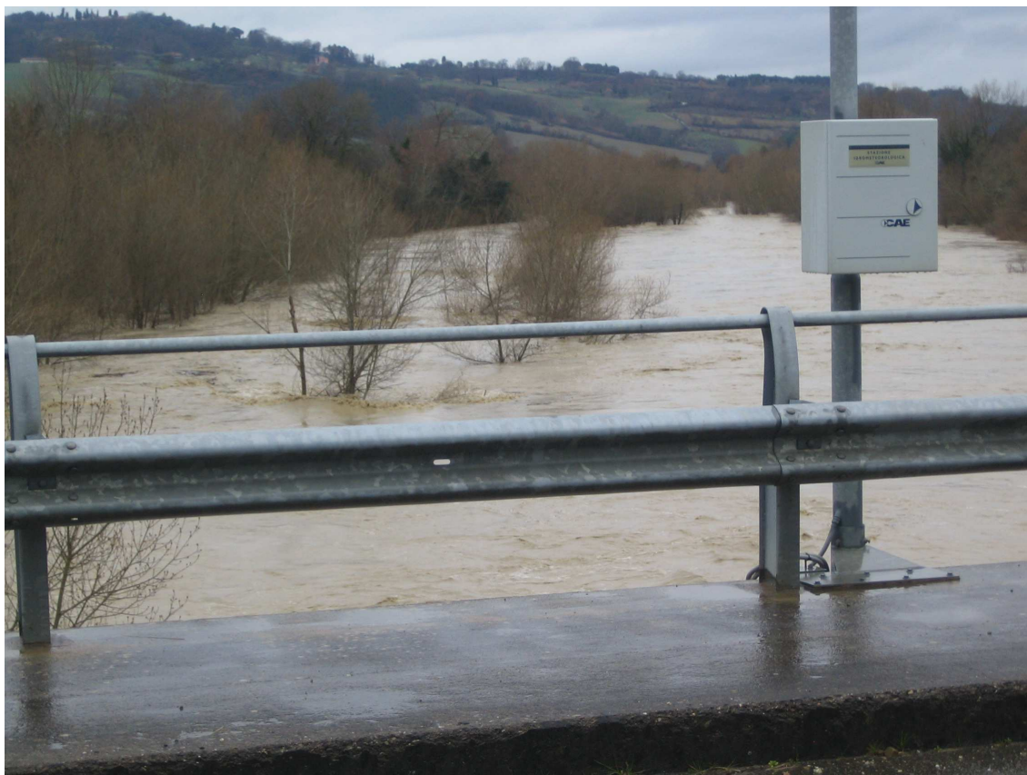
Stazione idropluviometrica Fiume Cecina Ponte SR 439
